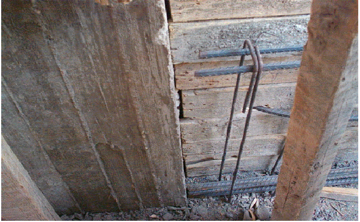
عدم تنفيذ الوصل بين حديد تسليح الكمرات المقلوبة والأعمدة
