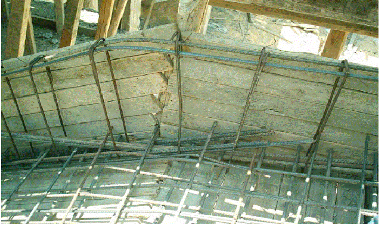
* عدم تنفيذ طول الرباط الكافى بين الاسياخ وعدم تقسيط الكانات
