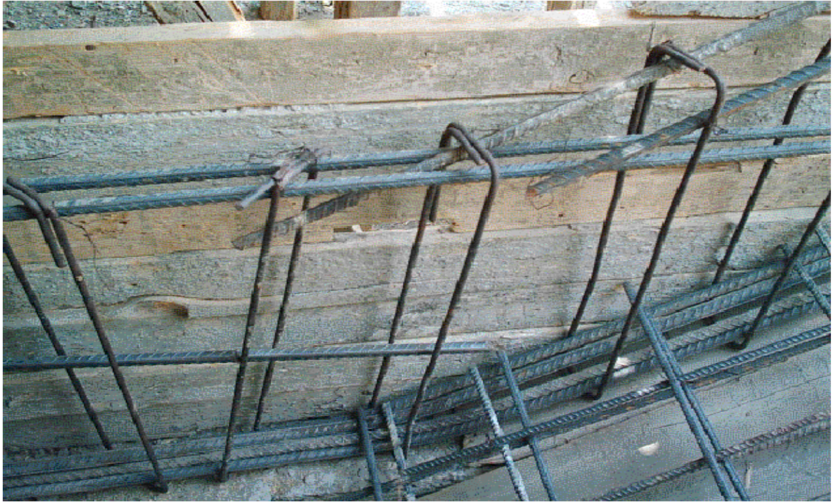
* عدم تنفيذ طول الرباط الكافى بين الاسياخ
